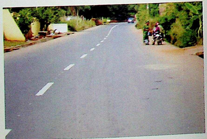
Completed Obeledu - Neni - Akwaeze - Igboekwu Road
