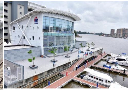
LASWA Jetty Terminal
